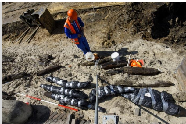
Inmiddels zijn veertig houten palen van een eeuwenoude brug aan de bodem ontfutseld op de Vestdijk. Foto: Jean Pierre Reijnen/fotomeulenhof
