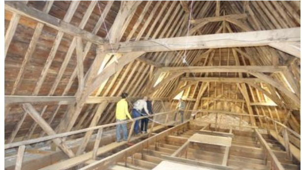
Over de loopbrug met uitzicht op de houten dakconstructie van de Sint Maartenskerk
