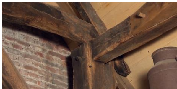
De ouderdom van de Aarlesche Hoeve is af te lezen uit de houtconstructie. Overgenomen uit de Pelserfilm
