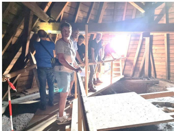
Bijzondere plek tussen de dakconstructie van de Sint Odulphuskerk
