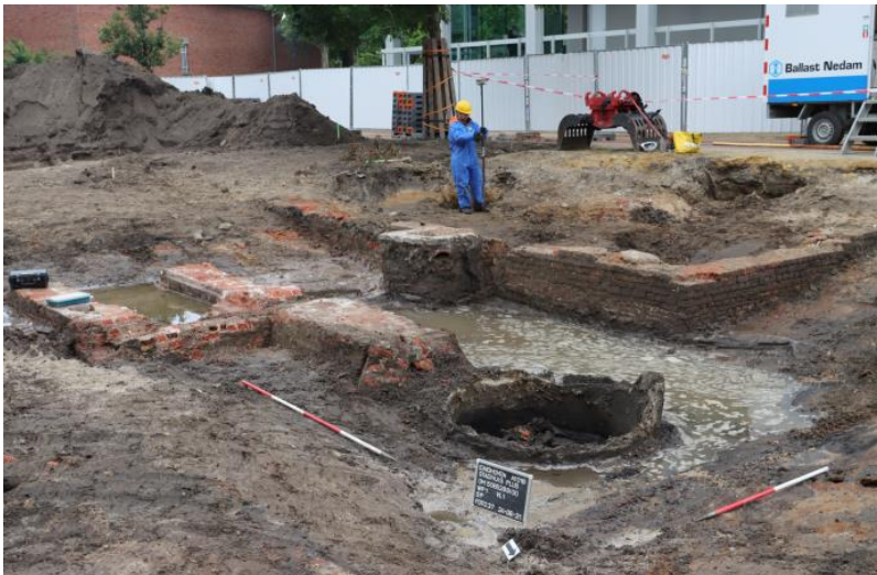
Een deel van de funderingsresten van 'Den Bouw' tijdens de werkzaamheden (bron: Bodac).
