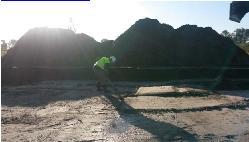
Aanleggen van de put
