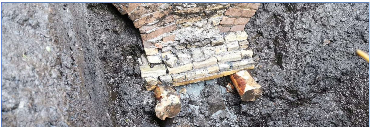
Afbeelding 3: Detail van de boogfundering met ijsselsteentjes en houten palen (foto Marc)
