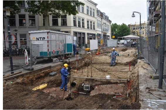
[afb 5: Documentatie van muurwerk in de riolsleuf door de Keizerstraat.]
