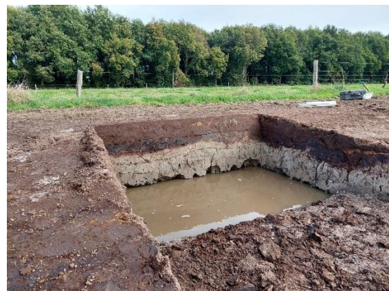
Afbeelding 51-1: Profielput in het ontgraven terreindeel.
