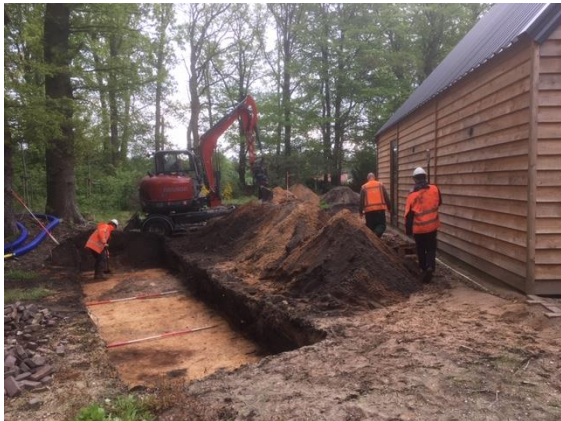
Afbeelding 34-1: aanleg van één van proefsleuven ter plaatse van de nieuw te realiseren vistrap.
