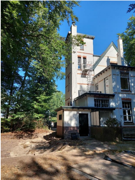
Afbeelding 17-1: één van de ontgraven bouwputten (links op de foto) voor de uitbreiding van de bestaande bebouwing
