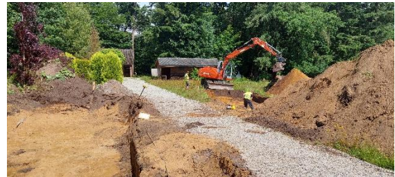
Afbeelding 13. Het aanleggen van een werkput aan de Miggelenbergweg 45.
