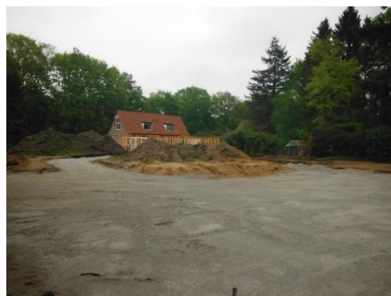
Afbeelding 3a. Overzichtsfoto van de reeds uitgevoerde werkzaamheden aan de Keienbergweg. Op een groot deel van het terrein was al granulaat gestort, waardoor het uitvoeren van een waarneming lastig was (foto: Econsultancy).
