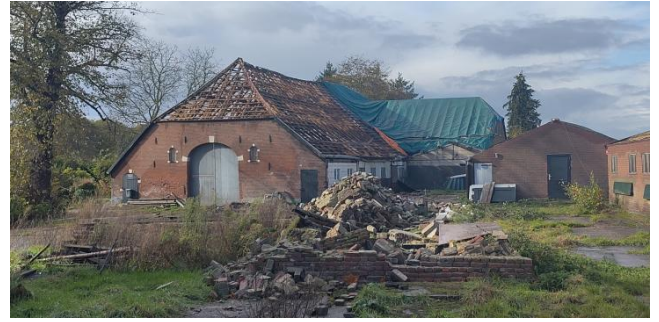
Afbeelding 8: Situatie van de sloop en herbouw van de schuur en boerderij (Gravenstraat 30). Boven de ingang van het restant van het (vermoedelijk 16 e -eeuwse) keldergewelf.
