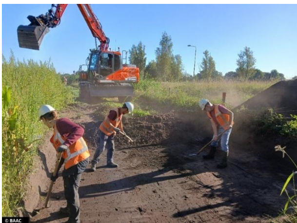
Afbeelding 5: Sfeerfoto tijdens de aanleg van de werkput.
