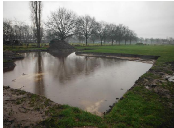
Afbeelding 3. De bouwput volledig onderwater gelopen (bekeken vanuit noordwestelijke richting) (foto: Sweco)
